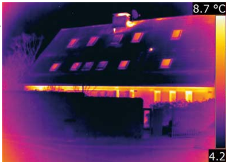
Während „kalte“, also in der Regel gut gedämmte Stellen an einem Gebäude, mit dunklen Farben wie violett, blau oder grün abgebildet werden, zeigen rote, gelbe oder weiße Stellen die Schwachstellen und Wärmebrücken eines Hauses auf.
